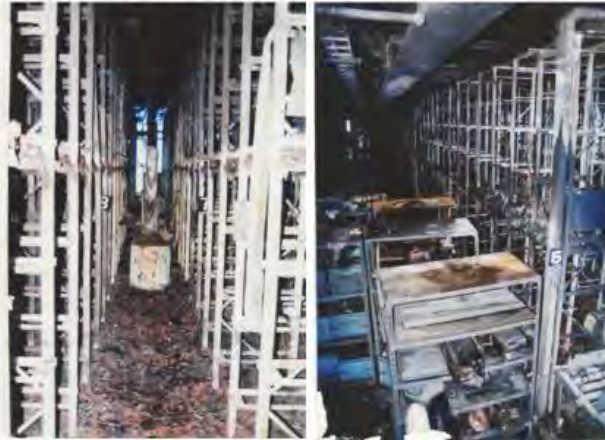
倉庫部分の焼損状況
